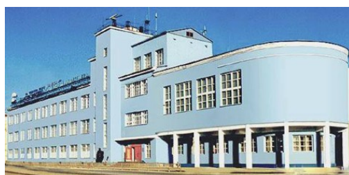
Вид здания мореходного училища в г. Мурманске (архитектурный стиль – конструктивизм)
